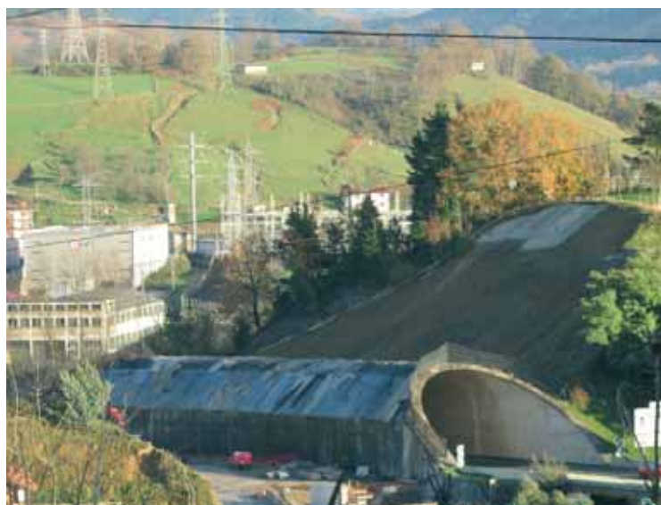
H1!-ek dio tunela kentzen bada, Igartzagainako subestazio elektrikorako beste sarbide bat egin beharko dela. Argazkia: H1!
