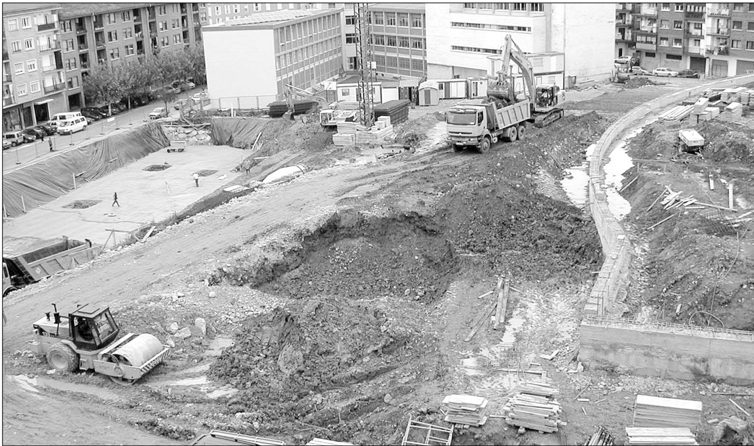
Agustinatako obretan eskabadora eta kamioi mugimendu haundia dabil.
