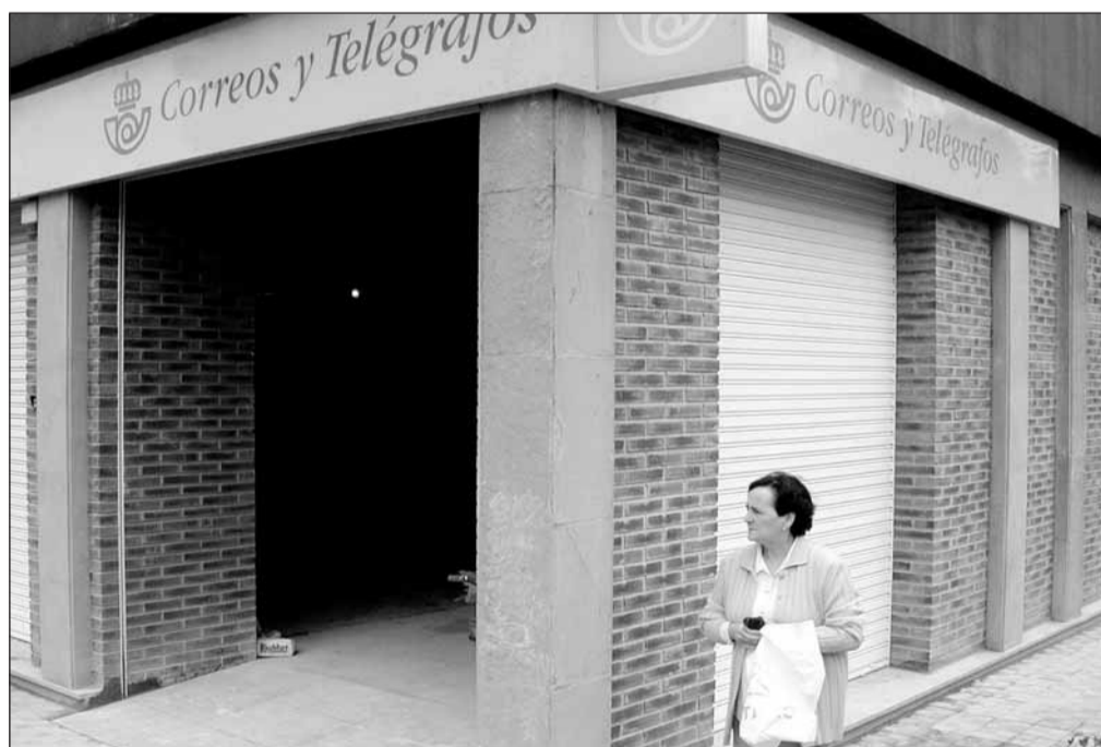
Korreseko bulegoa obretan dago eta ofizina probisional dago horren atzean bertan.
